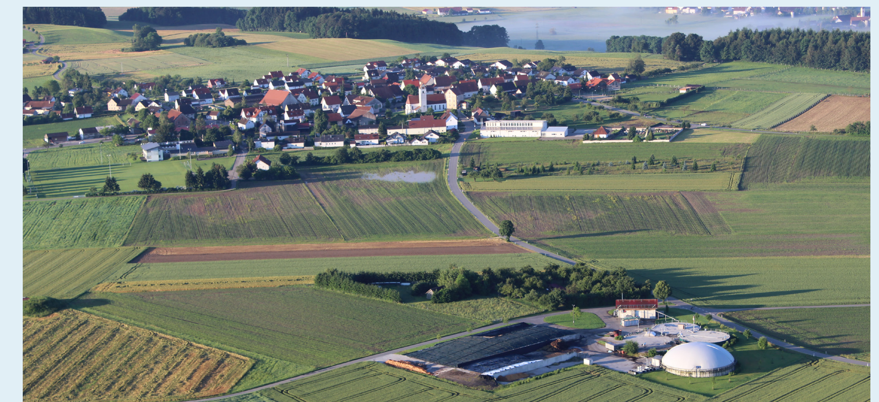
Die Biogasanlage firmiert unter: Bioenergie GbR W. Rapp und J. Volk-Daiber, das Nahwärmenetz in der Ortsmitte von Renhardswweiler unter: Neoenergie GmbH
