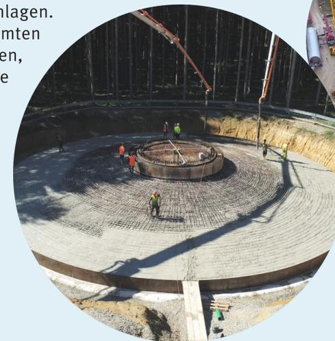
Betonfundament: Durchmesser 29 m
